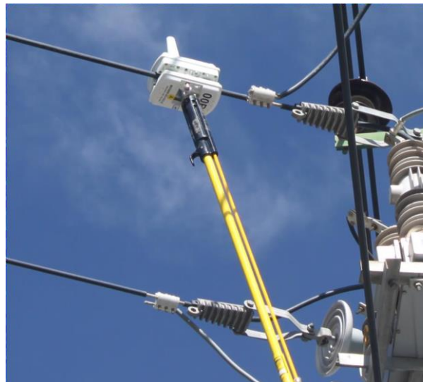
Rys.1. Instalacja czujnika MS5000 za pomocą drążka izolacyjnego.
